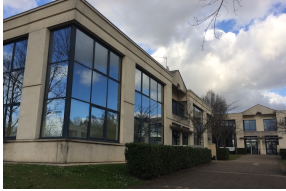
Le parc tertiaire Créteil Euro Parc © Cordell Partners
