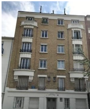
1 rue des Bruyères, 92600 Asnières-sur-Seine © Cordell Partners
